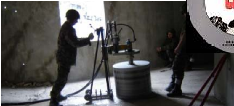
Übung im Umgang mit einer hydraulischen Maschine ... mit einem Durchmesser von 70cm
