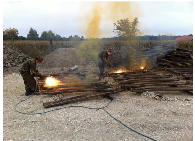
Foto: Rettungssoldaten zerschneiden die Geleise mit Sauerstofflanzen.
