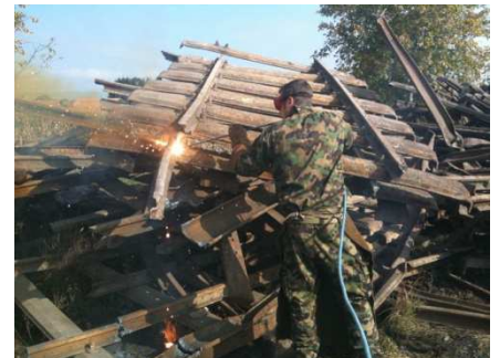
Foto: Die AdAs schneiden mit grosser Motivation die Geleise in Stücke.
